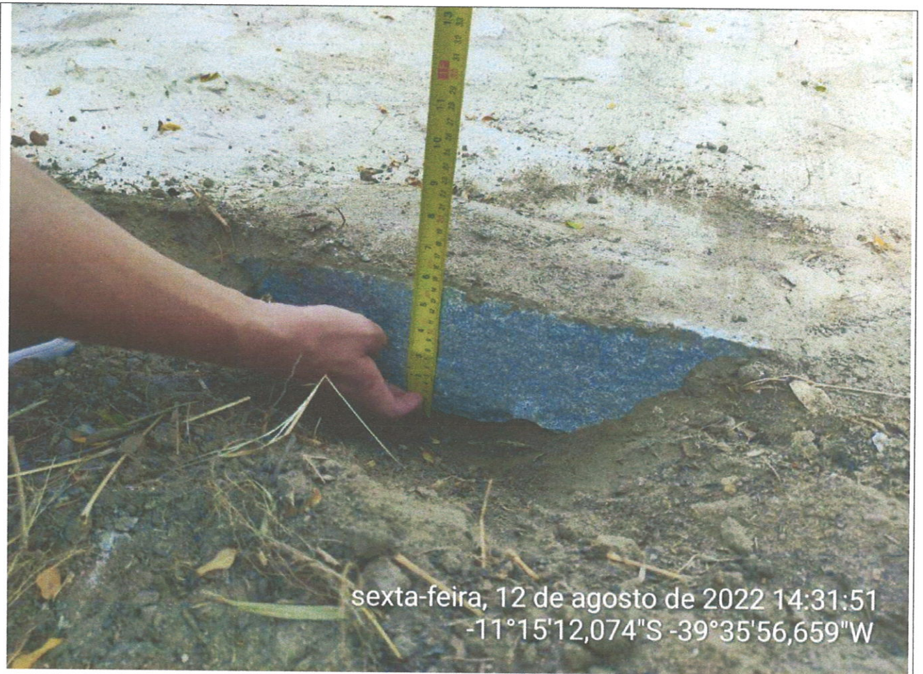
Espessura do Enrocamento Sentido Limeira
