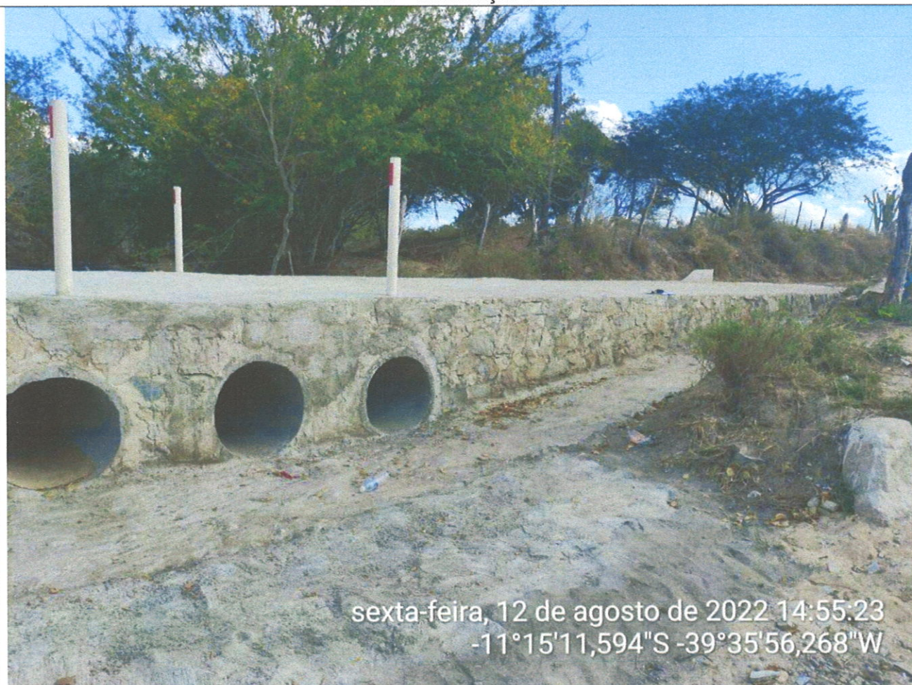
Foto 9 – Sinalização e Manilhas
