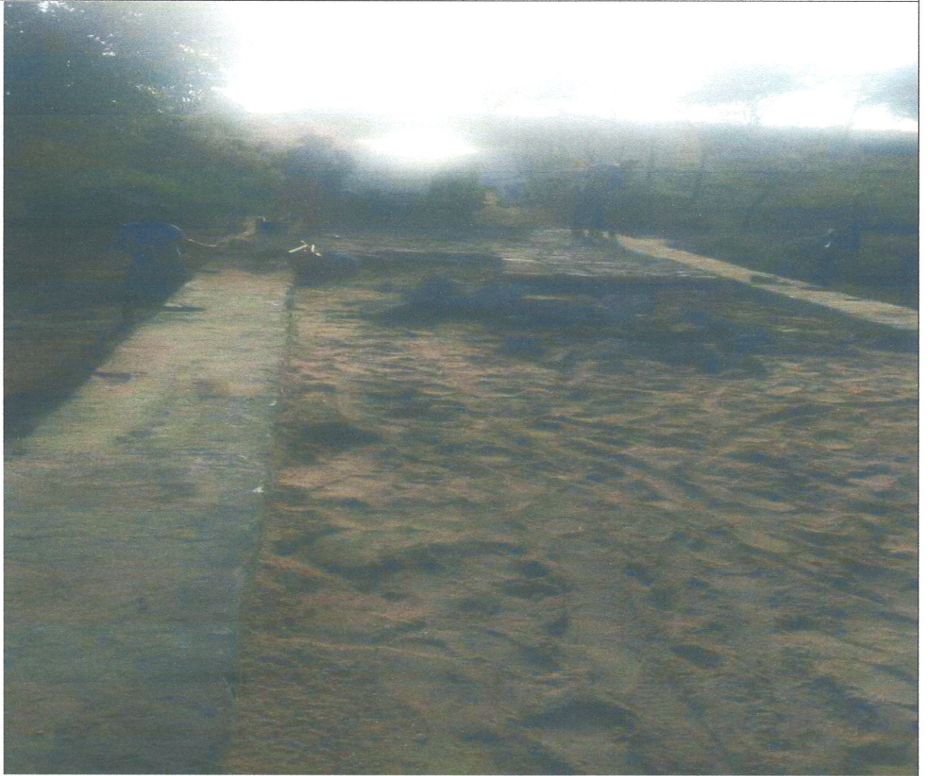
Foto 3 – Execução de Aterro
