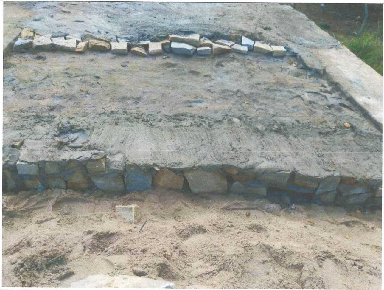
Construção de Piso em Alvenaria de Pedra
