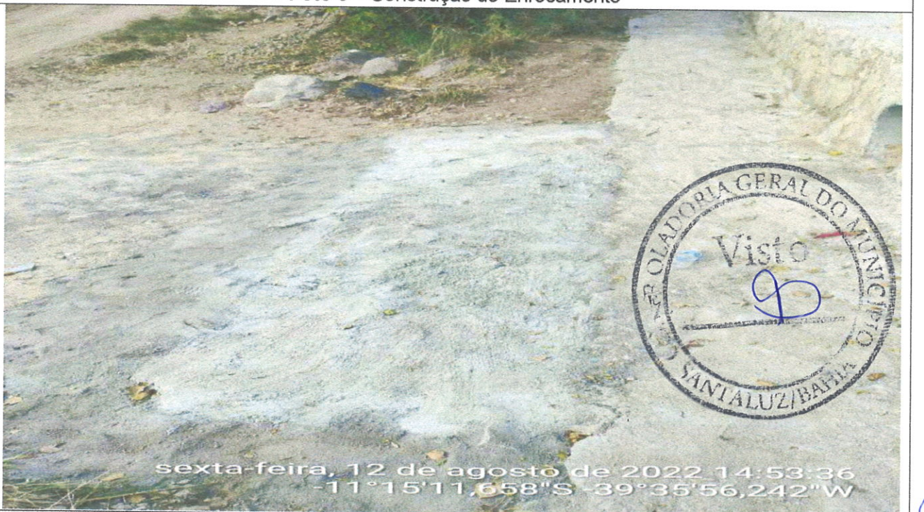
Foto 6 – Construção do Enrocamento
