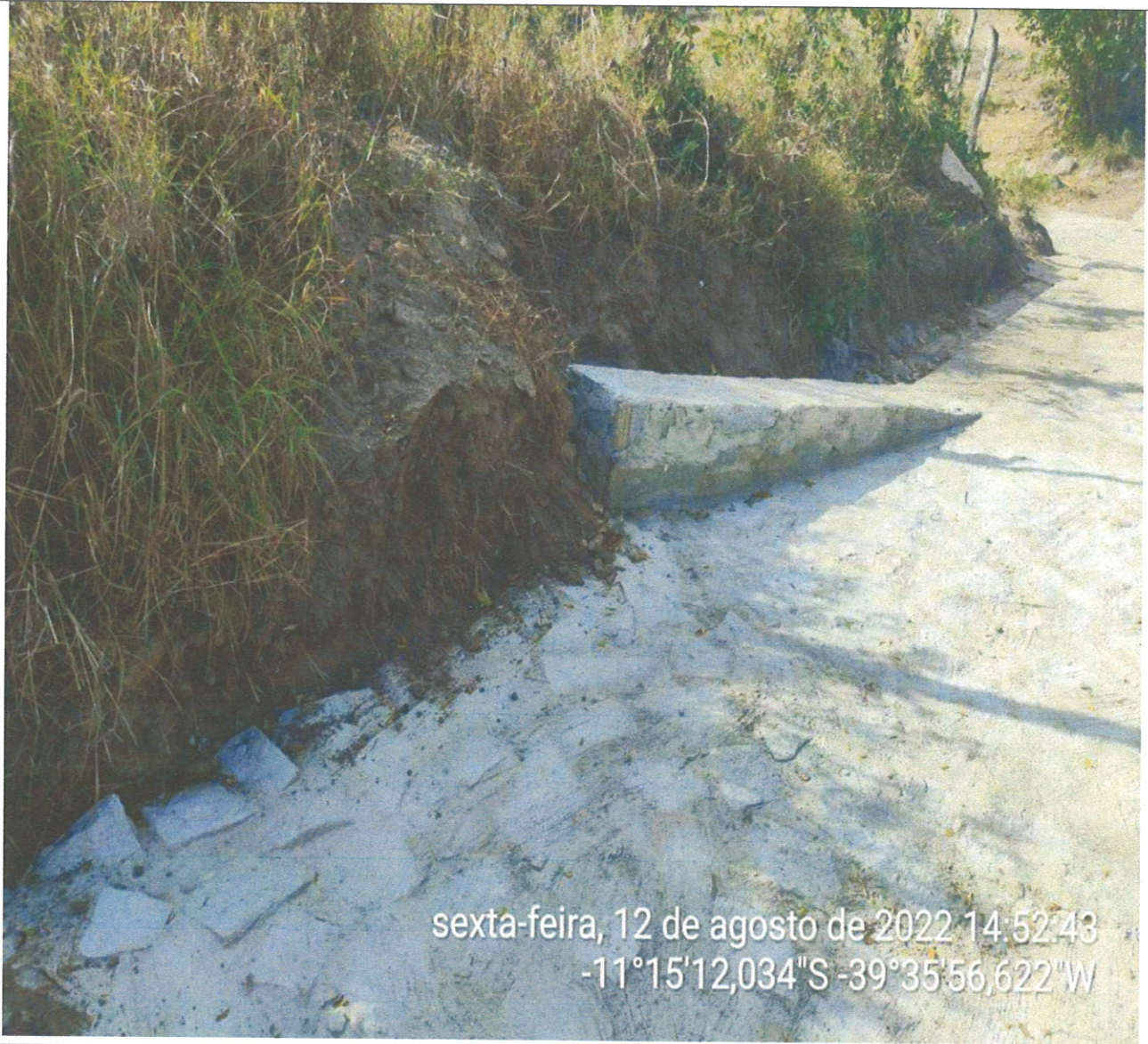
Construção da Abas direita sentido Sítio Novo 1 finalizada mais o enrocamento
