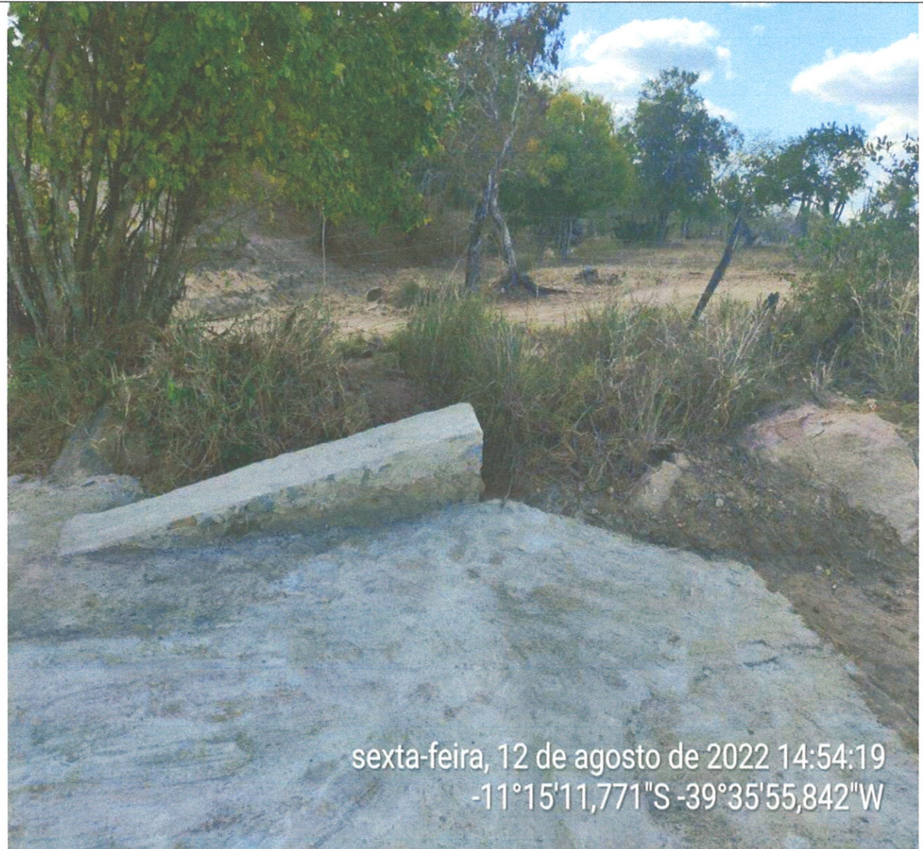
Foto 7 – Construção de Abas e do Enrocamento
