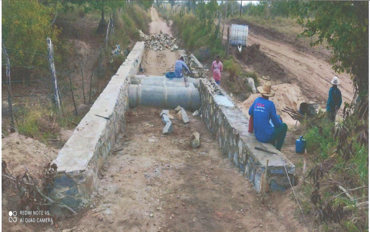
Foto 1 – Construção das Parede de Alvenaria
